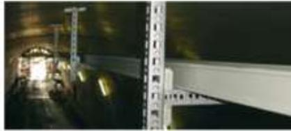
Abrutschsicher verzahntes, aus schockgeprüften MULTIFIX C-Profilen hergestelltes Trägermaterial garantiert Stabilität und Sicherheit.
