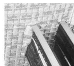
LANZ Sealbags in Deckenabschottung mit Gitter aus rostfreiem Stahl\* von unten gehalten
