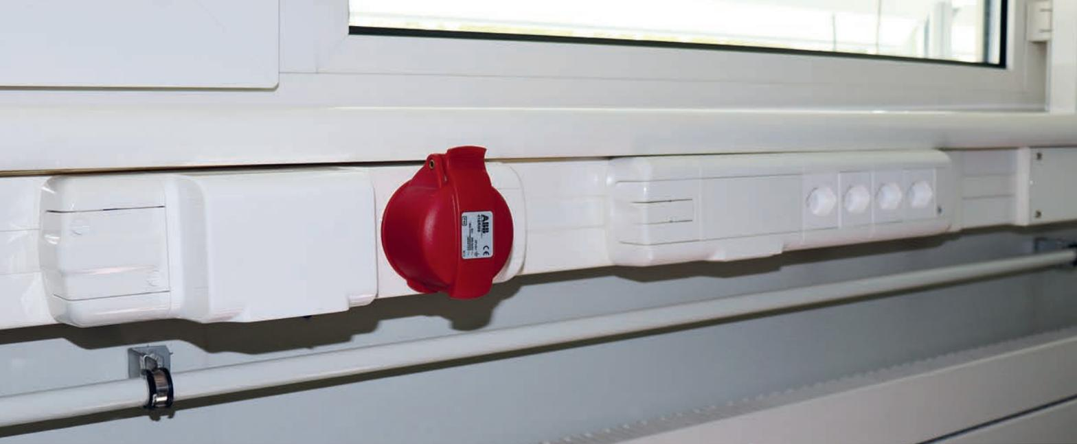
**Leitungsschutzschalter sind in den Abgangmodulen bereits integriert.**
