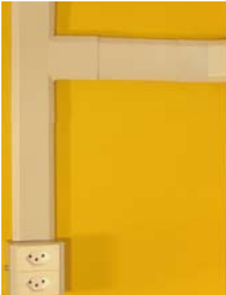
LANZ C-Kanäle montiert an Wänden.
