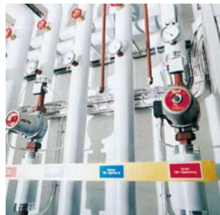
G-Kanäle – die ideale Kabelführung für die Technikräume.
