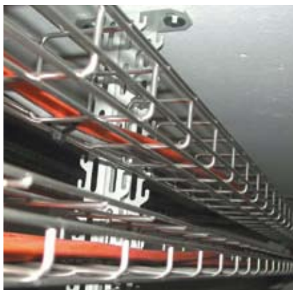
G-Kanäle untereinander an Hakenschienen-Deckenstützen montiert.
