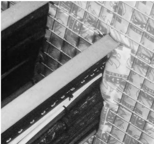
LANZ Sealbag in Deckenabschottung mit Gitter aus rostfreiem Stahl A4 von unten gehalten
