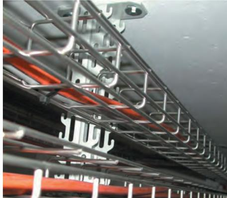
G-Kanäle hier untereinander an Hakenschiene-Deckenstützen montiert.
