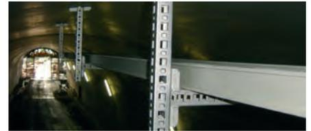
Abrutschsicher verzahntes, aus schockgeprüften MULTIFIX C-Profilen hergestelltes Trägermaterial garantiert Stabilität und Sicherheit.
