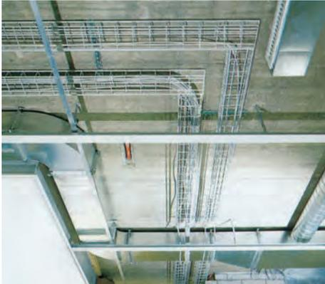
G-Kanäle Platz sparend direkt unter der Decke montiert. Nur 56 mm hoch!
