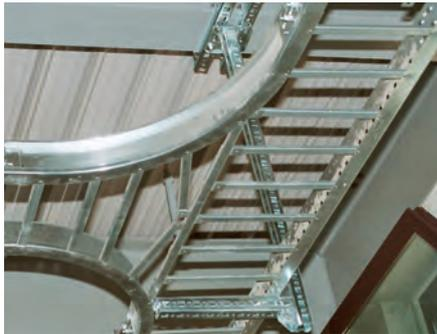
Abrutschsicher verzahntes, aus schockgeprüften MULTIFIX C-Profilen (siehe Seite 108f.) hergestelltes Trägermaterial garantiert Stabilität und Sicherheit.
