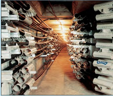
LANZ BIG-Installation in einem städtischen Versorgungsnetz. Montage beidseitig an der Wand. – Beachten Sie, dass platzsparende Montagen zusätzlich auch mit den bügelförmigen Boden-/Deckenbefestigungen gemacht werden können.
