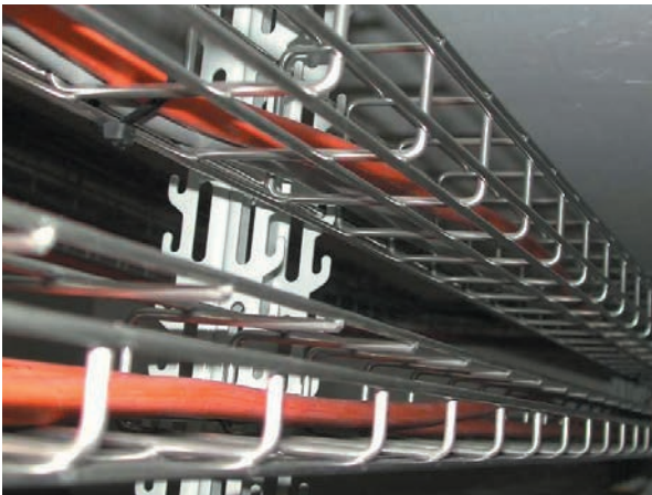
Deckenmontage: Rostfreie G-Kanäle untereinander an Hakenschienen-Deckenstützen montiert.
