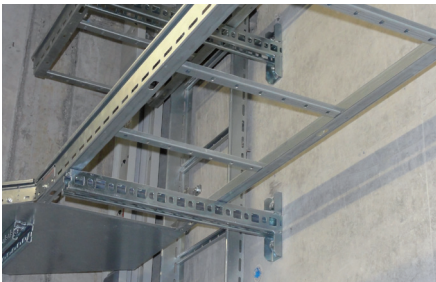
LANZ Kabelpritschen sind Top Qualität tauchfeuerverzinkt
