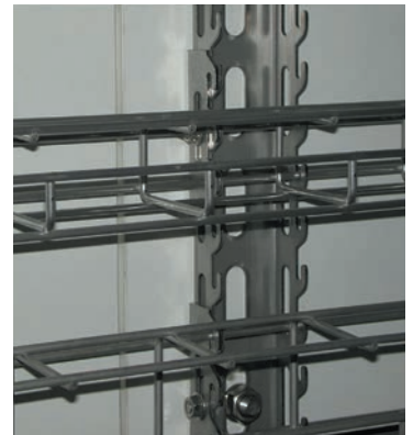
Mehrere LANZ G-Kanäle aus rostfreiem Stahl A4 an 1 Hakenschiene standard an einer Betonwand eingehängt. Sicherung mit Blockierblech.
