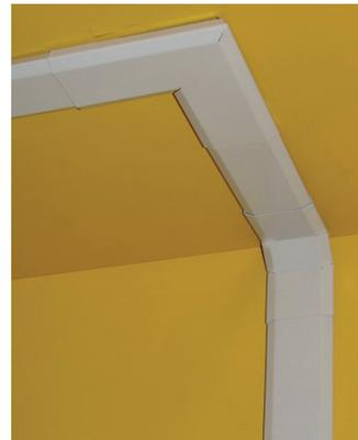
LANZ C-Kanäle sind ideal für die Montage im Deckenbereich.
