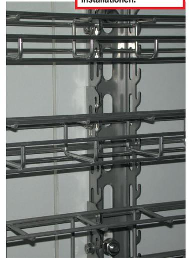
Mehrere LANZ G-Kanäle aus rostfreiem Stahl A4 an 1 Hakenschienenstandard an einer Betonwand eingehängt. Sicherung mit Blockierblech.
