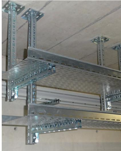
LANZ Trägermaterial: Solide und bewährt aus erstklassigem Rohmaterial A4 WN 1.4404.
