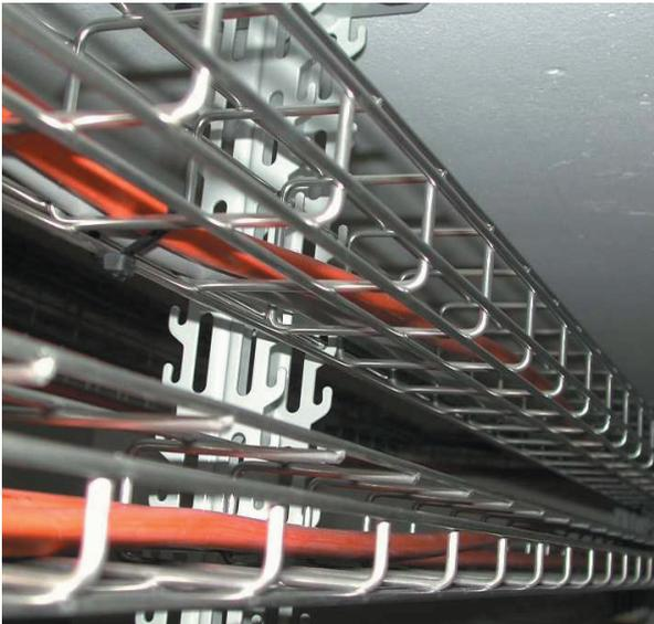
Deckenmontage: Rostfreie G-Kanäle untereinander an Hakenschienen-Deckenstützen montiert.
