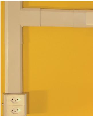
LANZ C-Kanäle montiert an Wänden. Beachten Sie die Steckdosen!
