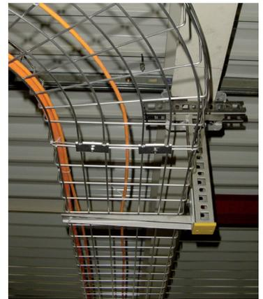
LANZ Gitterbahnen aus rostfreiem Stahl A4 im Kompressorenraum eines Chemiebetriebes
