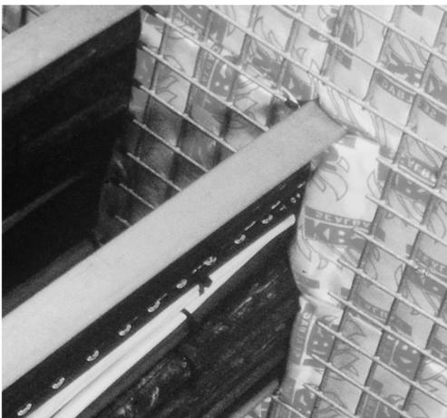
Die LNZ Sealbag Brandschutzkissen werden nach dem Kabeleinzug gleichmässig oder im Verbund geschichtet in die Aussparung eingelegt und zgedrückt. Sie können ganzflächig, gefaltet oder kombiniert aus verschiedenen Typengrössen platziert werden. Hohlräume sind zu vermeiden, da nur dann **feuer- und rauchgasdichte** Abschottungen gewährleistet sind. Die Schottdicke beträgt für S 30 mindestens 20 cm, für S 90 mindestens 35 cm. Fragen Sie LNZ bei Unklarheiten an!
