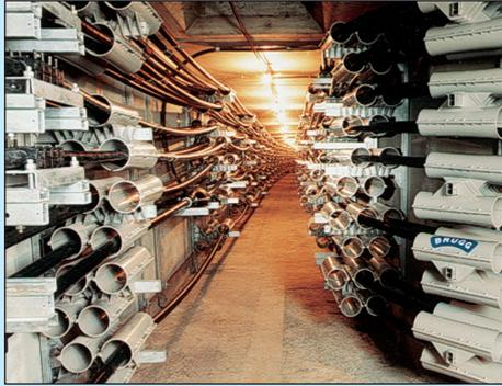
LANZ Briport-Installation in einem städtischen Versorgungsnetz. Montage beidseitig an der Wand. – Beachten Sie, dass platzsparende Montagen zusätzlich auch mit den bügelartigen Boden-/Deckenbefestigungen gemacht werden können.
