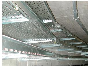
Kabelbahnen und Weitspann-MB aus rostfreiem Stahl A4, Seiten 28-37 und 38-47
