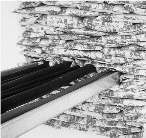
LANZ Sealbag Brandschutzkissen eignen sich für provisorische oder definitive Abschottungen von Kabeldurchführungen durch Brandabschnitte in Gebäuden. LNZ Sealbag **quellen unter Brandeinwirkung auf** und härten aus. Brandabschottungen mit LNZ Sealbag sind bei Nachinstallationen in Kürze entfernt und in Kürze durch den Elektroinstallateur wieder erstellt und funktionsbereit.
